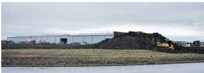
Die Erdarbeiten sind seit Januar in vollem Gange. Im Hintergrund sind 2020 errichtete Inoclad-Produktionshallen zu sehen. Foto: gm
